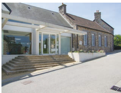
Travaux d'accessibilité à la médiathèque
