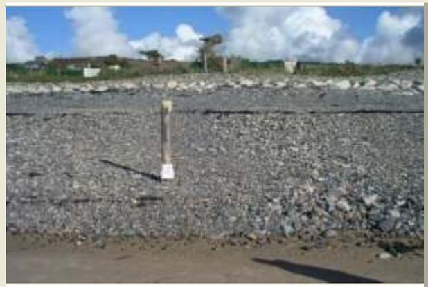
Située à environ 100 m au Sud de l'accès à la plage "le Fortin" au Nord de l'Anse de Scioto, au droit d'un cordon en enrochement de faible hauteur, partiellement recouvert par des galets.
