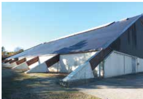
Rénovation de la toiture de la salle Polyvalente en octobre pour un montant de 32 000 €.
