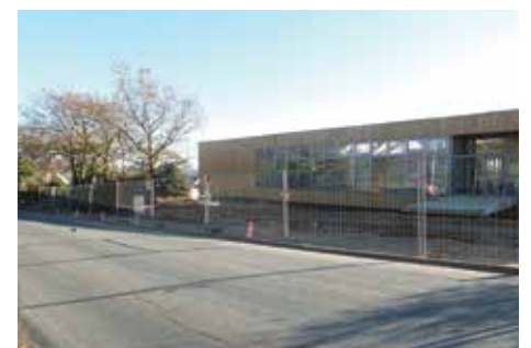
Aménagement piétons et création d'un arrêt de bus aux abords du pôle enfance. Fin des travaux au 1 er semestre 2017
