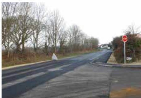
Sécurisation de l'entrée de ville par la RD 4 avec mise en place d'un plateau surélevé. Fin des travaux en janvier 2017.
