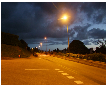
Les éclairages LED sont utilisés sur toute la commune
