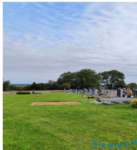
Avant le début des travaux
