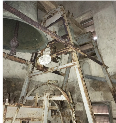
Avant le début des travaux
