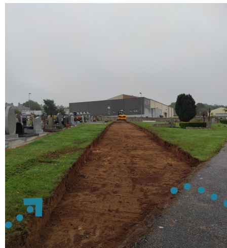
Pendant les travaux
